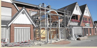
Rundbogen im Giebelhaus: Der Eingangsbereich im Schulhaus Baar erhält ein neues Gesicht. Und die Orthopädie-Abteilung bekommt einen zusätzlichen Raum.
